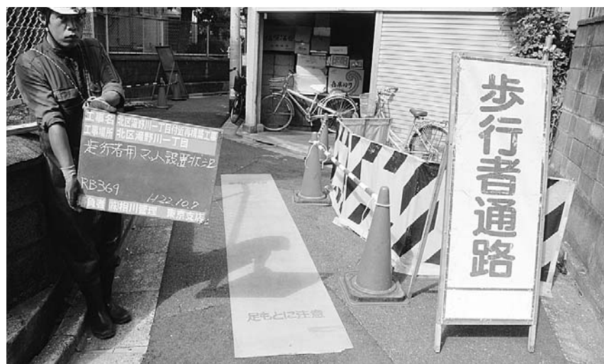
道幅約2mの狭小道路での施工
